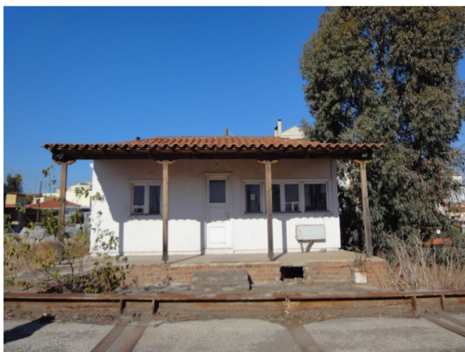
Εικόνα 1. Ο σταθμός μέτρησης ατμοσφαιρικής ρύπανσης (ΣΜΑΡ) του ΟΛΒ
