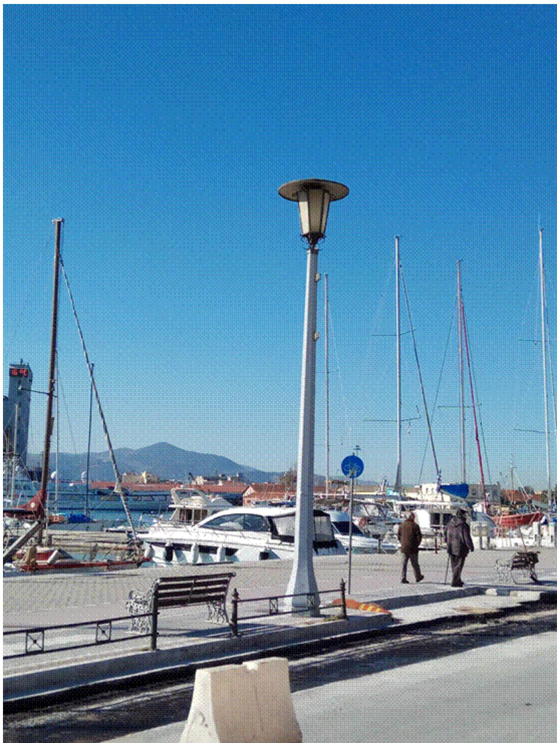
2. Μεταλλικός ιστός (διακοσμητικού τύπου-πυροφάνι), ύψους 4 μέτρων με λαμπτήρα 250W
