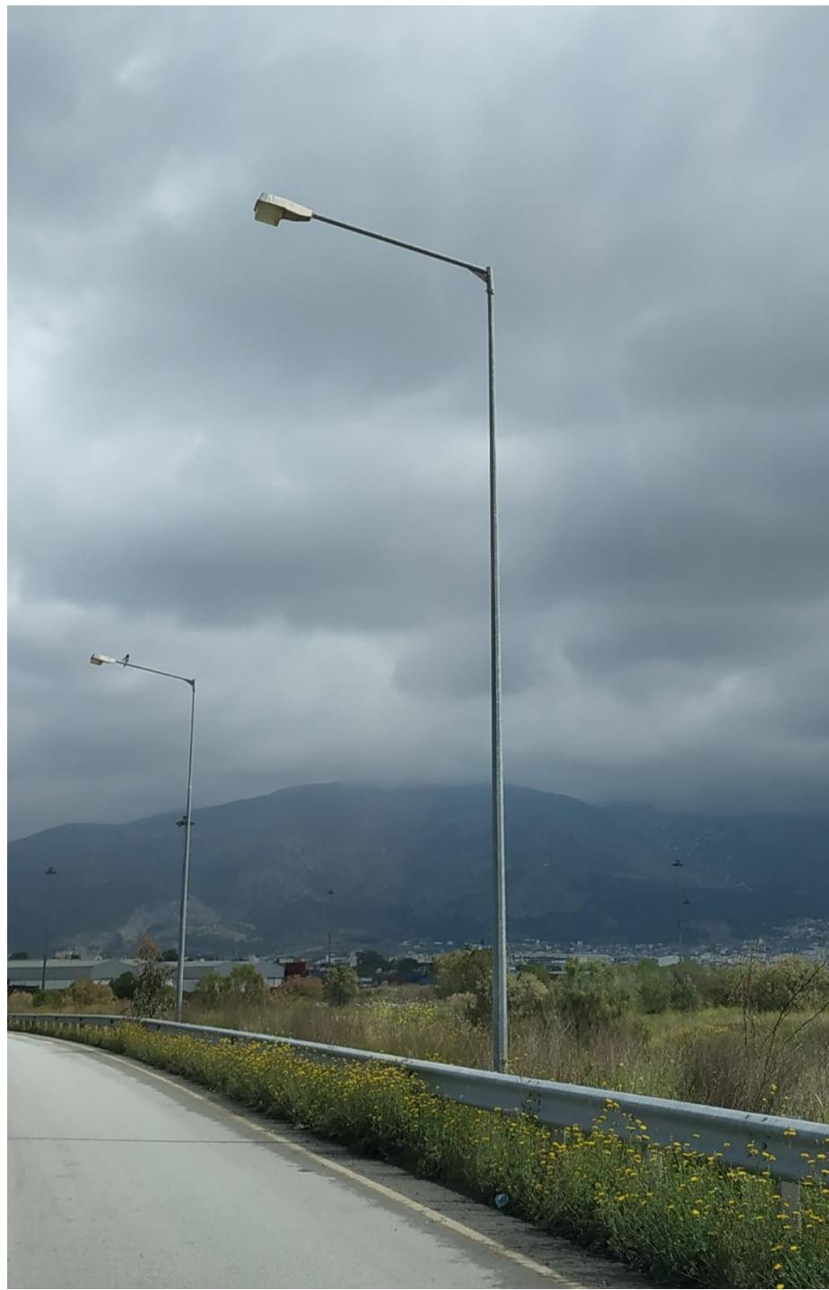
4. Μεταλλικός ιστός (φωτιστικό δρόμου), ύψους 6 μέτρων με λαμπτήρα 250W
