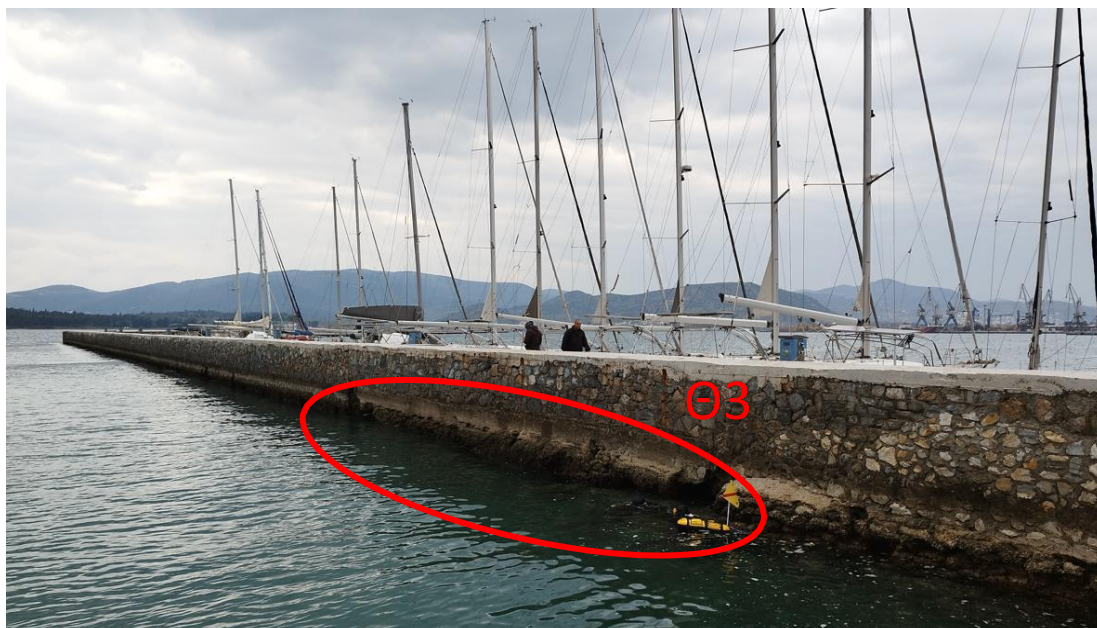
Εικόνα 2.8 Έξαλη και ύφαλη εσοχή διαστάσεων 0.80 \times 3.00 \times 1.35 (υ x π x β) στην προσήνεμη πλευρά του προστατευτικού τοιχίου [Θέση: Θ3]
