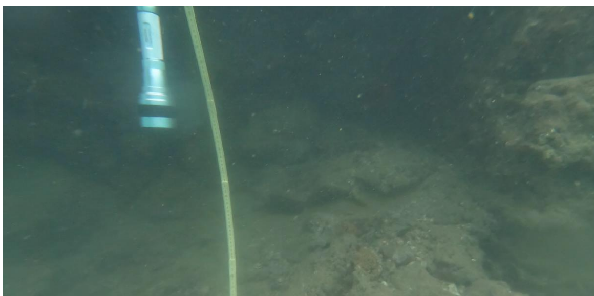
Εικόνα 2.11 Ύφαλη εσοχή διαστάσεων 1.40 x 1.30 (υ x β) [Θέση: Θ6]
