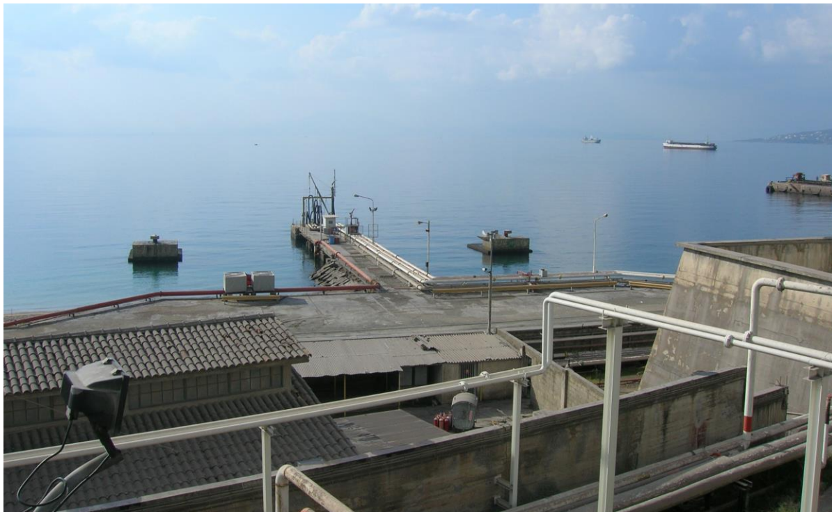
Φωτ. ΙΙ.Ε.1: Γενική Άποψη Εγκατάστασης
